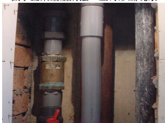
沖廁水喉銅製減壓掣有輕微生銹
