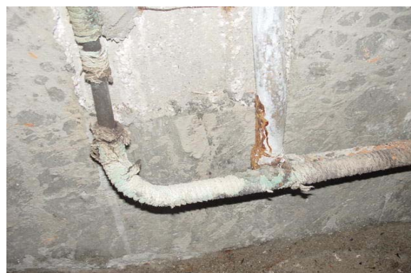
連接浴缸及洗手盆龍頭的熱水喉，以石棉繩包裹
